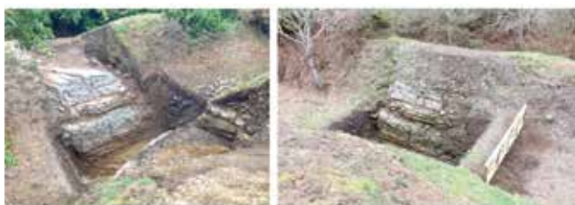
Fig. 6. Terceiro parapeto e segundo foso despois da limpeza e da restauración
