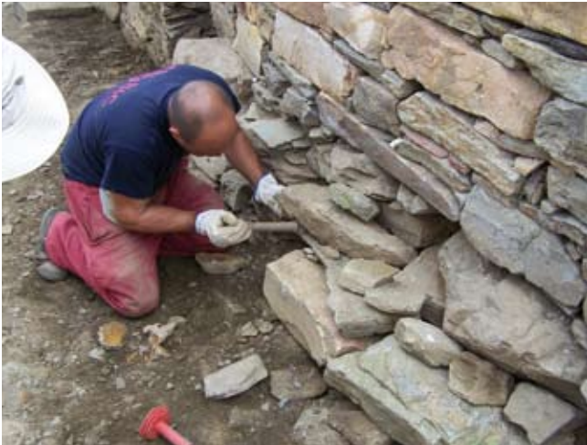
9.2 Recalzando o muro
