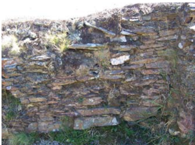
7.1 Estado inicial antes da intervención
