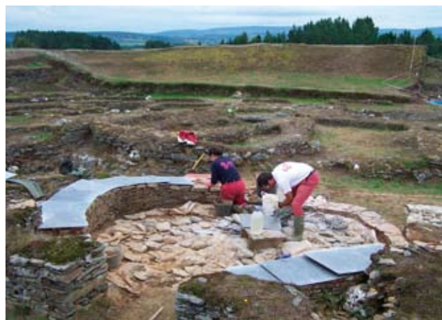
3.5 Protección da cabeceira dos muros
