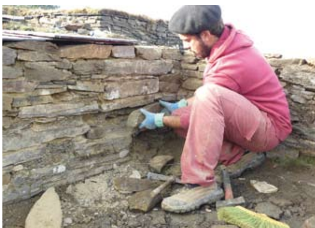
3.3 Substitución de laxes deterioradas por outras en bo estado
