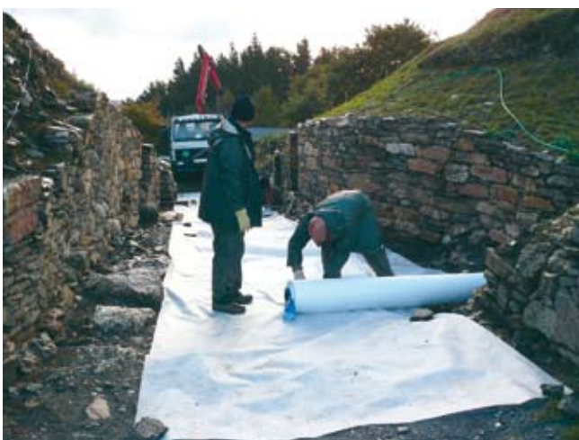
8.2 Colocación de xeotéxtil
