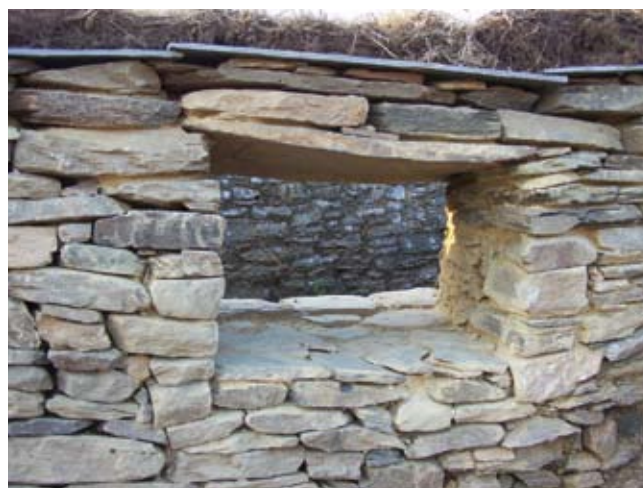
7.2 Estado final tras a restauración do muro
