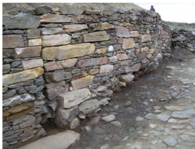
9.1 Muro descalzado
