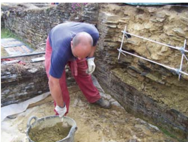
6.2 Colocación dunha armazón de fibra de vidro
