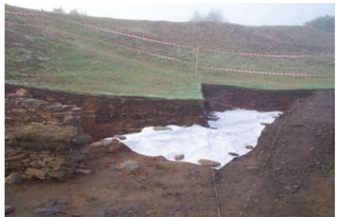
10.2 Protección con xeotéxtil
