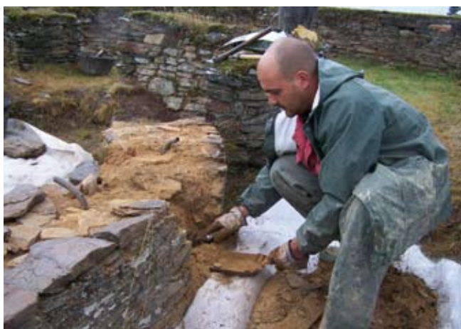
3.2 Desmonte dun muro
