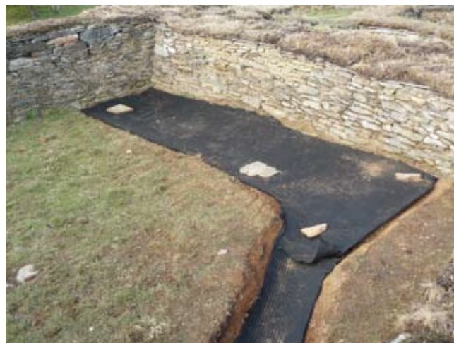
6.3 Colocación da drenaxe
