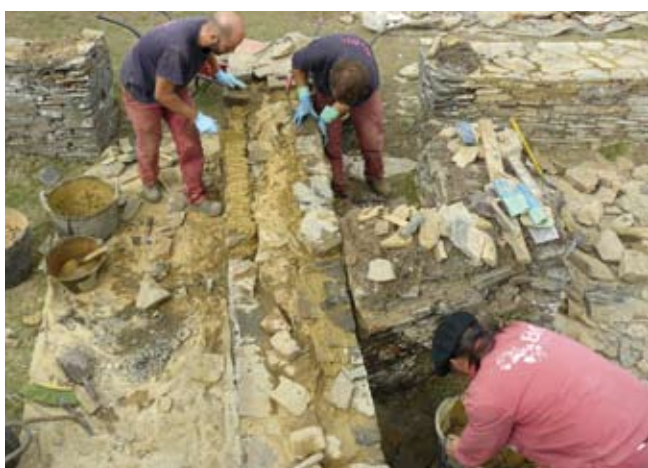
3.4 Colocación de morteiro e pedra
