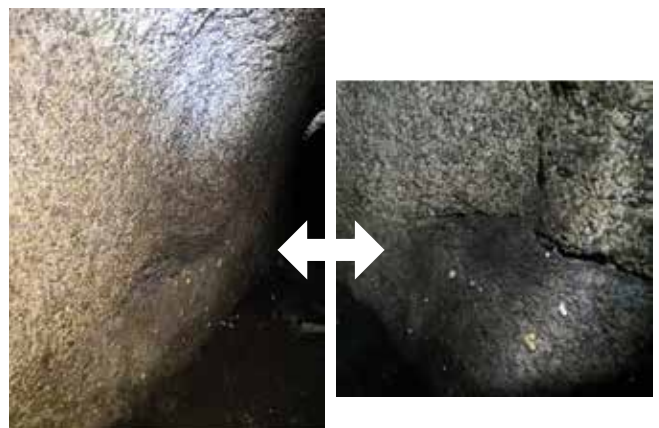
Fig. 6. Posible lucernario escavado na parede do túnel e detalle do mesmo. Foto A. P. R.
