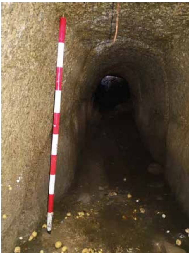
Fig. 7. Interior do túnel á metade de percorrido. En primeiro plano a colonia de fungos que cobre case todo o chan. Foto A. P. R.
