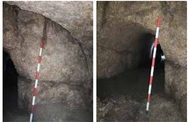
Fig. 5. Fotografías do túnel dende unha das galerías de entrada. Foto A. P. R.
