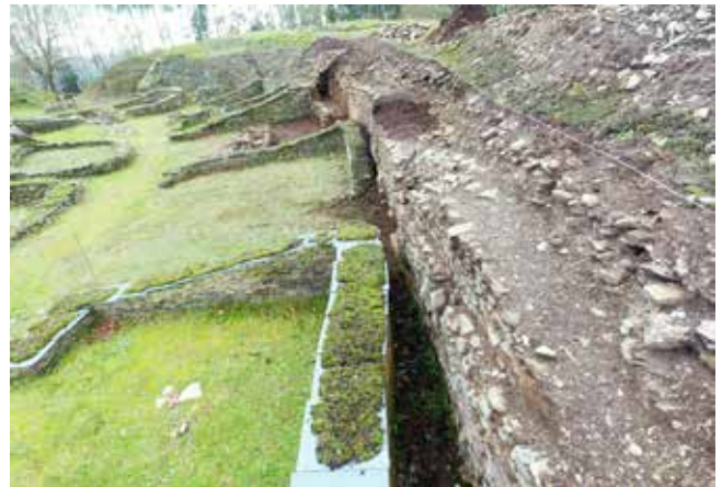
Figura 8. Traballos de escavación e restauración no sector 2 na muralla norte
