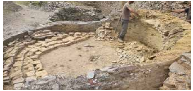
Figura 7. Traballos de anastilose dos muros relacionados para a súa posterior restauración
