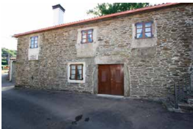
Vista exterior do edificio matriz Casa do Patrón.
