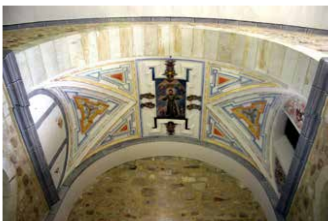
Bóveda restaurada en iglesia de Santa Lucía.
