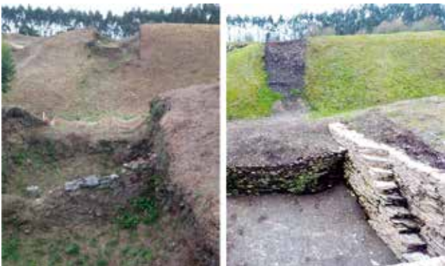
Fig. 3. Vista do primeiro e segundo parapetos antes e despois da intervención.
