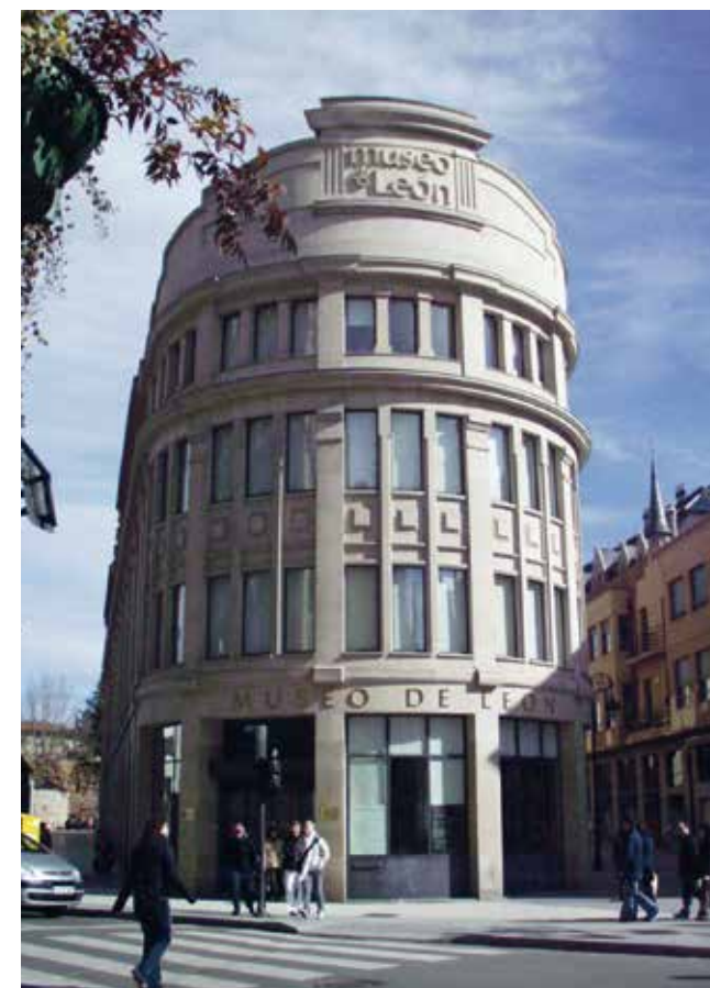
Fig. 6. El edificio Pallarés, antiguos almacenes comerciales y sede actual del Museo.
