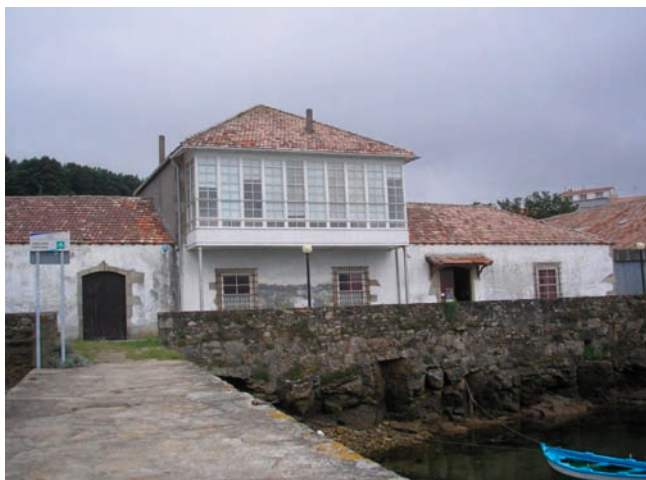
Entrada Este, por el Paseo marítimo.
