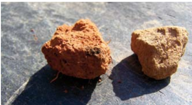
Detalle das argamasas orixinais de arxila.
