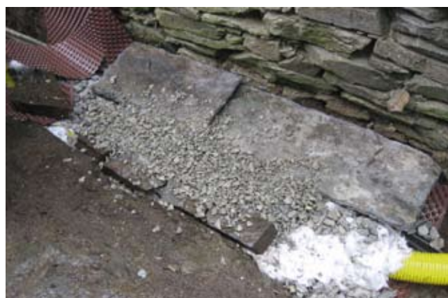
Execución da gabia de drenaxe
