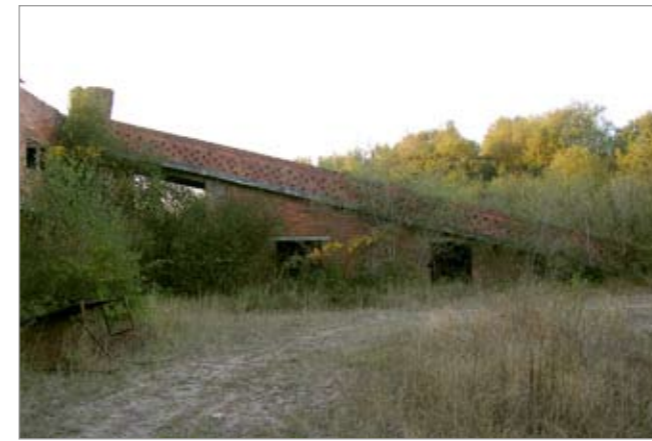
Rampla de acceso dende a barreira ao muíño.
