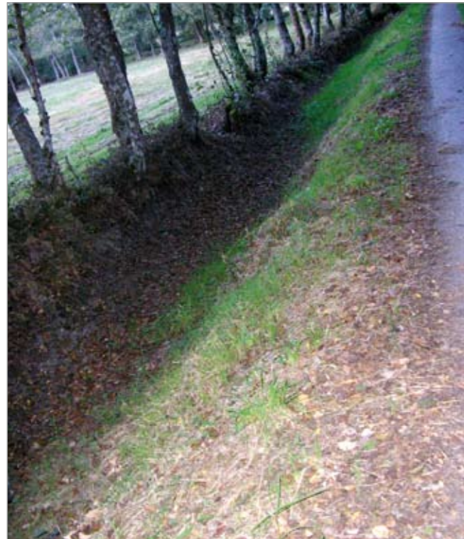
Antiga cata para comprobar a profundidade do barro.
