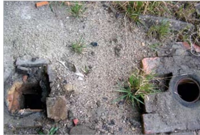
Buracos no teito do forno para introducir serrín e casca, carbón ou fuel.
