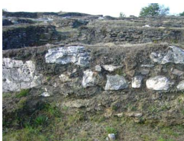
Imaxe 8: Sobreescavación do muro e exposición dos alicerces.
