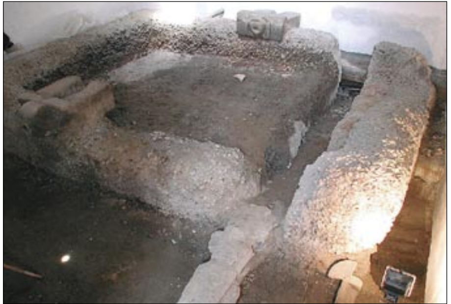
Vista del estanque, en la que se aprecia la destrucción provocada por la conducción eléctrica y la capa de residuos industriales en el fondo y en las paredes
