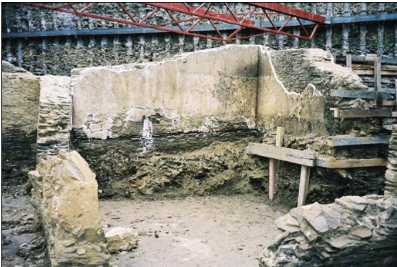
Excavación y consolidación de la pintura conservada in situ en la estancia 2100.
