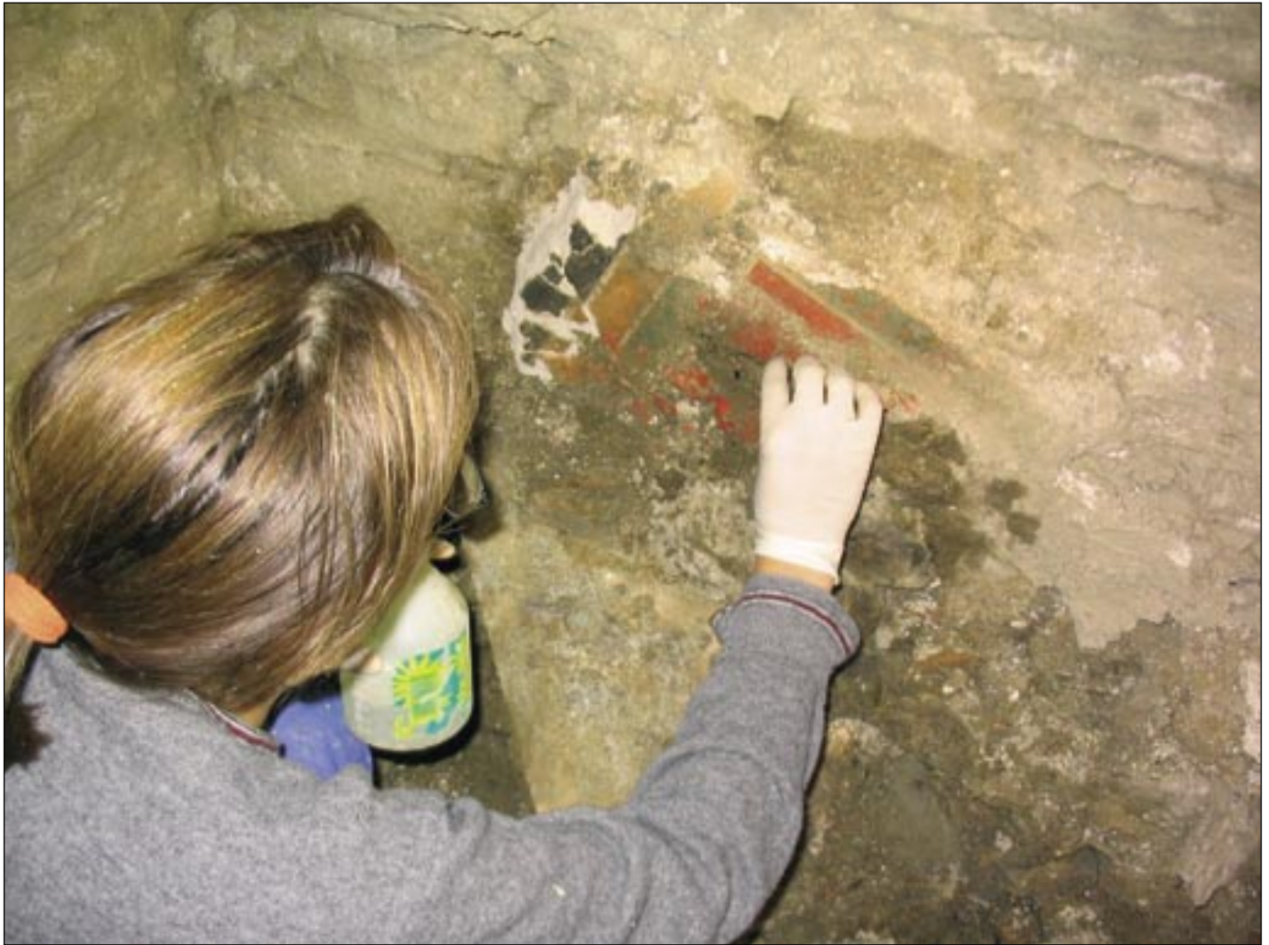
Consolidación de un fragmento de pintura desprendida del muro, para proceder a su extracción
