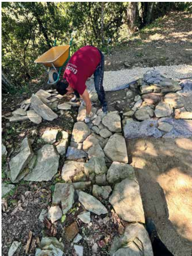
Fig. 26. Traballos de recheo dun muro para evitar a acumulación de auga.
