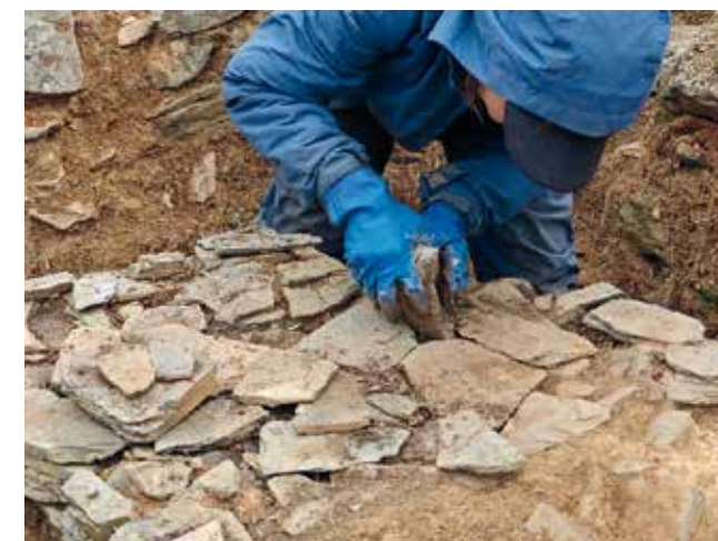
Fig. 13. Proceso de recheo dos ocos e galerías creados por animais no interior dos muros do horreum .
